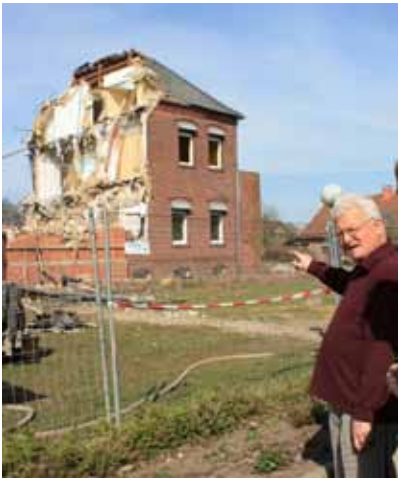
Haus St. Vitus: Abriss des alten Krankenhauses
